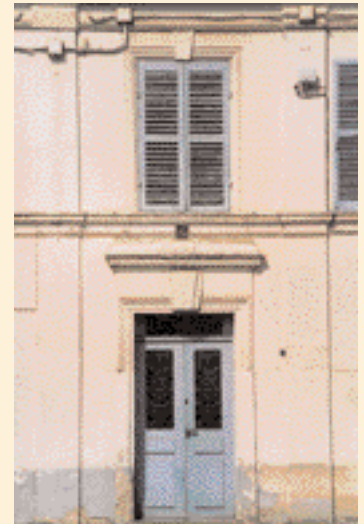
Soubassement et menuiseries sont dans les tons gris-bleu. ▼
